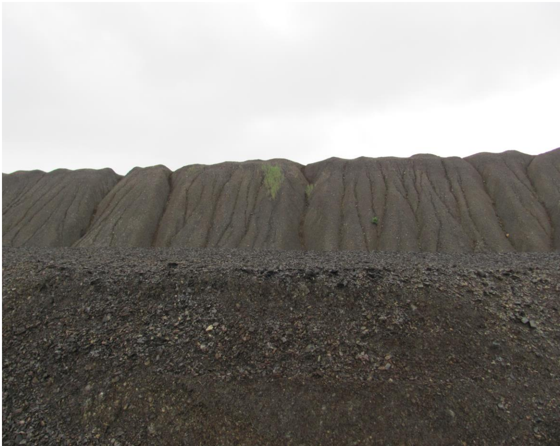
Рис. 2.9. Ерозійні процеси на схилі відвалу Центральної збагачувальної фабрики.
