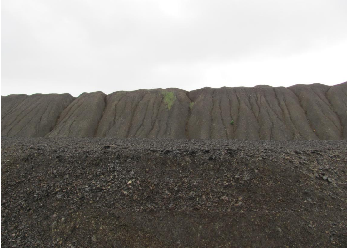
Рис. 2.3. Ерозійні процеси на схилі відвалу Центральної збагачувальної фабрики.
